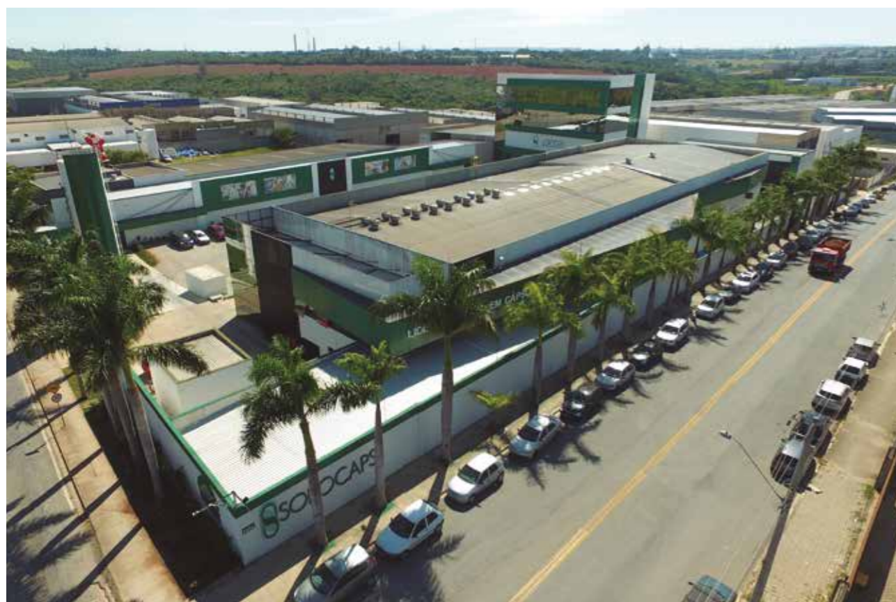
Localizado em Sorocaba (SP), complexo fabril da Sorocaps ocupa uma área de 10.000 m 2
